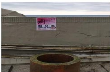
機械、商船系館 5 樓外陽台
