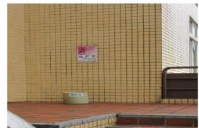
電機二館後側空地
