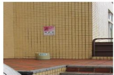
電機二館後側空地
