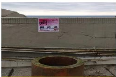
機械、商船系館 5 樓外陽台
